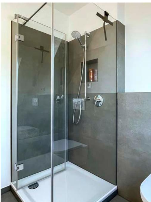
**Die Duschtrennung besteht aus einem Festglas-Element an der Seite und vorne einer Tür mit Pendeltürbeschlag neben einem kleinen Festteil.**
