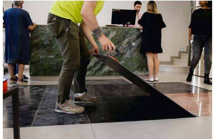
Verlegung der Fliesen auf der Klebefolie
