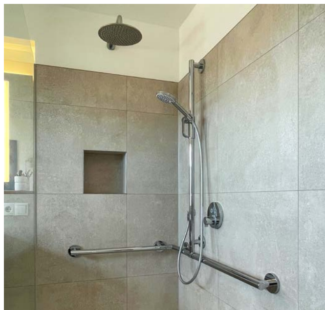
Für mehr Sicherheit in der Dusche sorgt ein Relingsystem. In Kombination mit der Brausestange bietet es seine Hilfe unauffällig und optisch ansprechend an.
