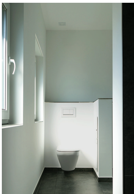
Gegenüber dem Eingang ermöglicht eine halbhohle Wandscheibe eine intime Nische für das WC.
