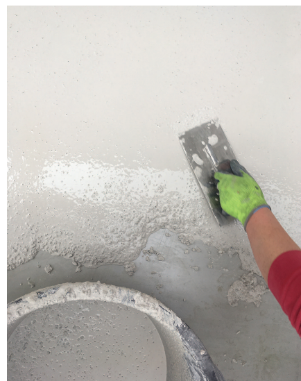
Die Trockenmischung wird mit Wasser angerührt, aufgeschachtelt und geglättet.
