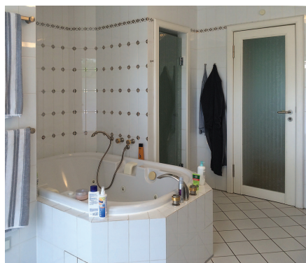
Vor der Sanierung stand die große Whirlwanne im Zentrum, die allerdings nicht mehr benutzt wurde.
