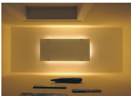
Unkonventionell: Der Heizkörper wurde auf einer Platte an die Decke montiert und rundum mit LED-Stripes versehen.
