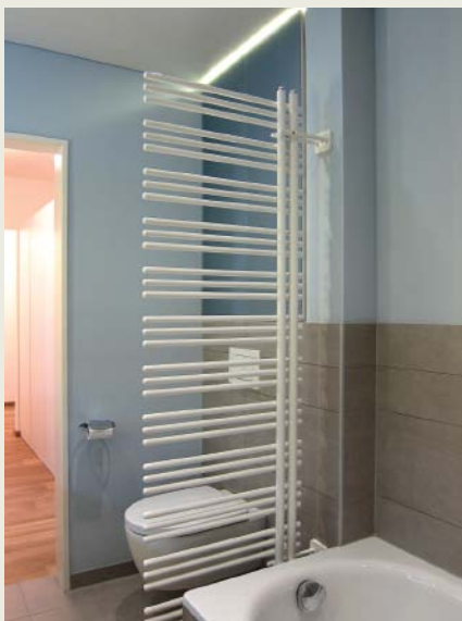
Der Handtuchheizkörper dient als Raumteiler, um das WC abzutrennen.
