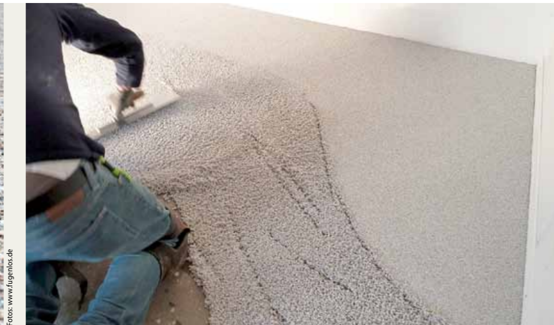
Der „Steinteppich“ wird flüssig verlegt.
