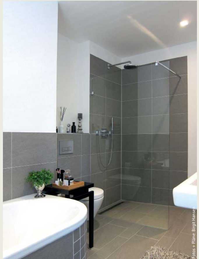
2 Beim Fitnessbad sind Dusche und WC vertauscht, am Boden sind die Fliesen mit zwei Formaten im wilden Verband verlegt.
