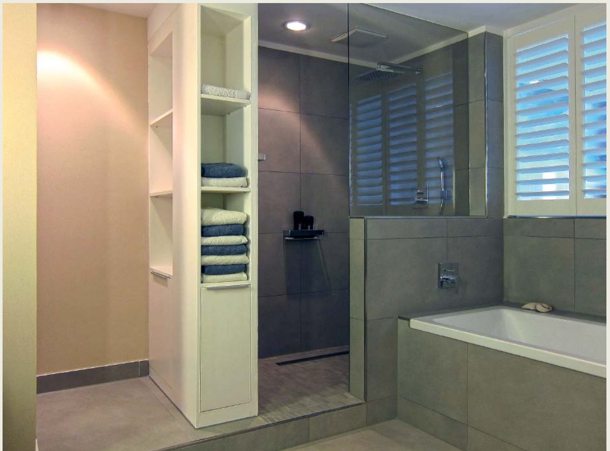
Der Duschbereich musste erhöht werden, weil die nötige Einbauhöhe für eine bodenebene Dusche nicht vorhanden war. Über der Wanne ist ein Festglaselement eingebaut.
