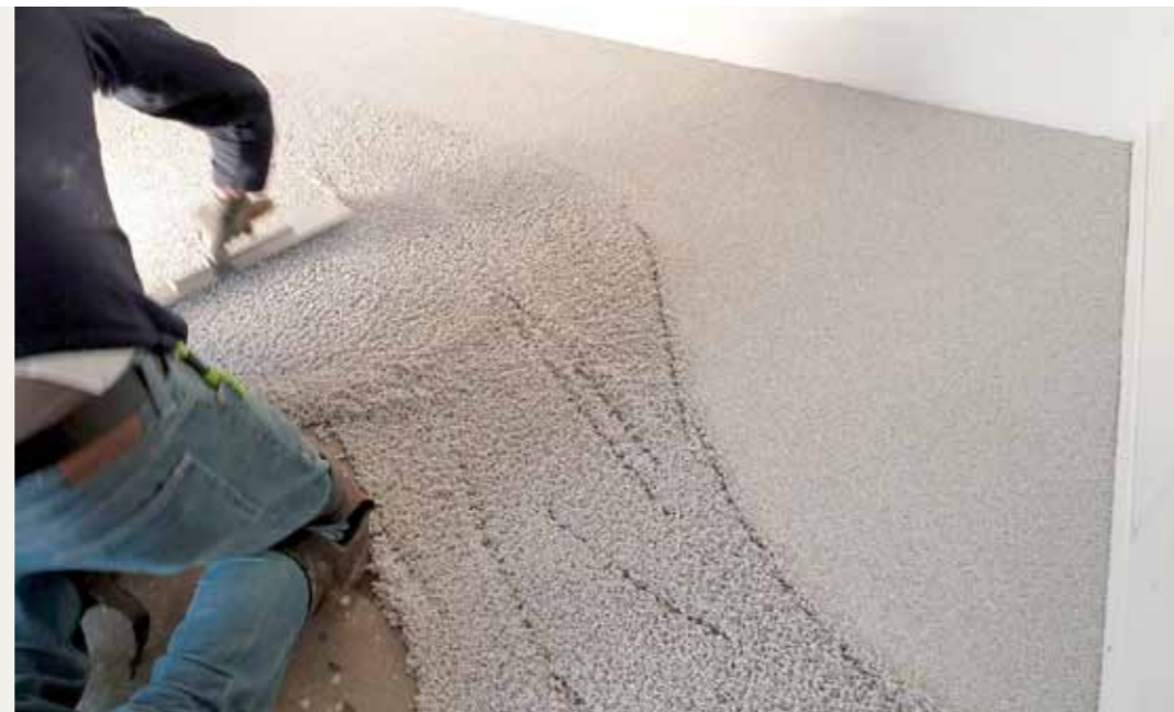
Der „Steinteppich“ wird flüssig verlegt.
