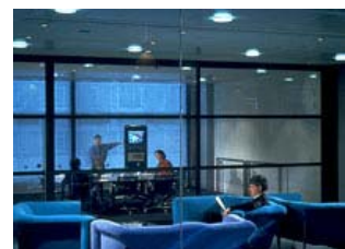
Elektrooptisches Glas: auf Knopfdruck werden opake Scheiben klar durchsichtig
